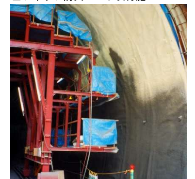
■フィップ防火コート吹付施工
