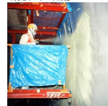
■発泡ウレタン吹付施工
